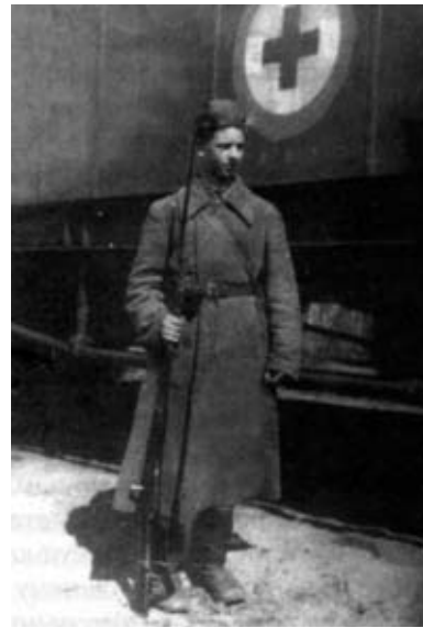
Охрана военно-санитарного поезда. Июль 1943 года
