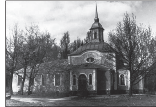
Церковь Святых апостолов Петра и Павла при больнице им. Императора Петра Великого архитекторы Л. А. Ильин и А. В. Розенберг, 1912–1914 гг. Фото 1914 г. ( http://info-petersburg.ru )...
