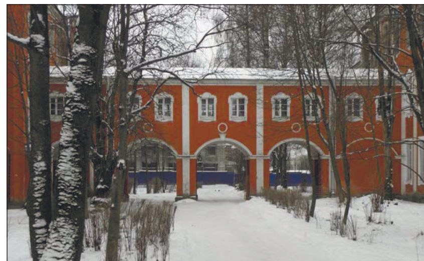
Переход между хирургическими клиниками
