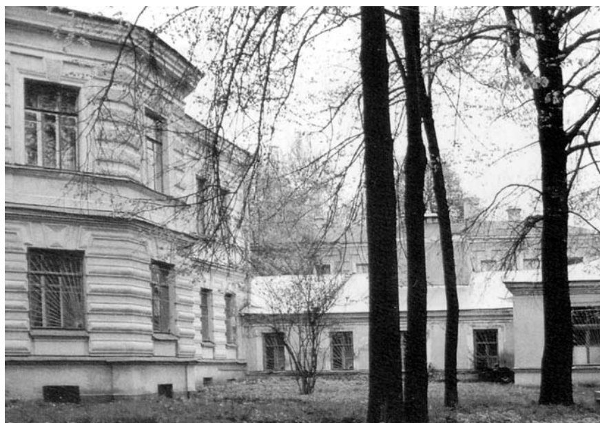
Так выглядел корпус имени Э.Э.Эйхвальда до реконструкции. Фото 1998 г.
