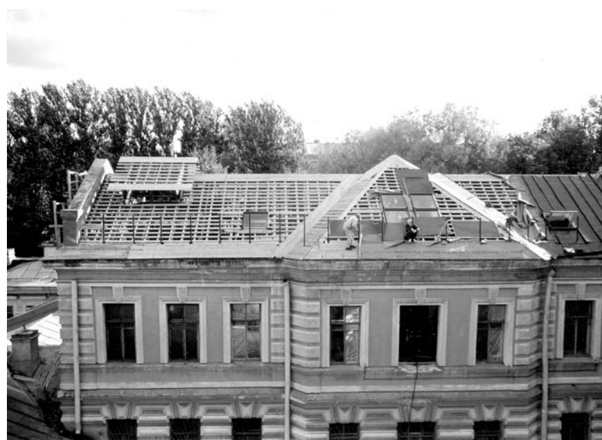
Возведение мансардного этажа
