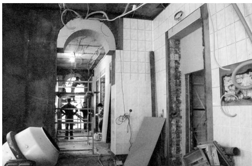
Корпус имени Э.Э.Эйхвальда в процессе реконструкции
